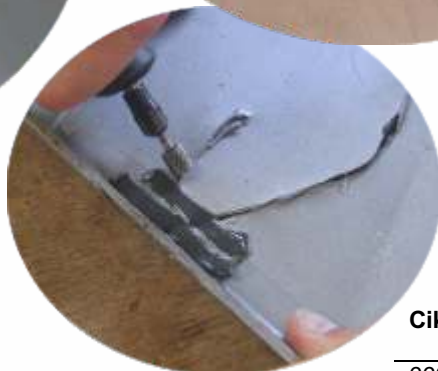
Hegesztési fuga készítése homlokmaróval.
