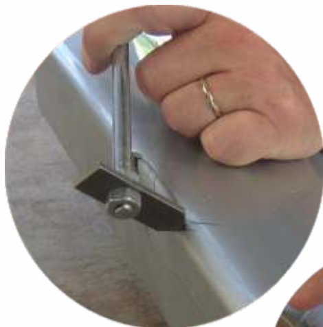
Hegesztési fuga előkészítése kétélű kaparóval.
